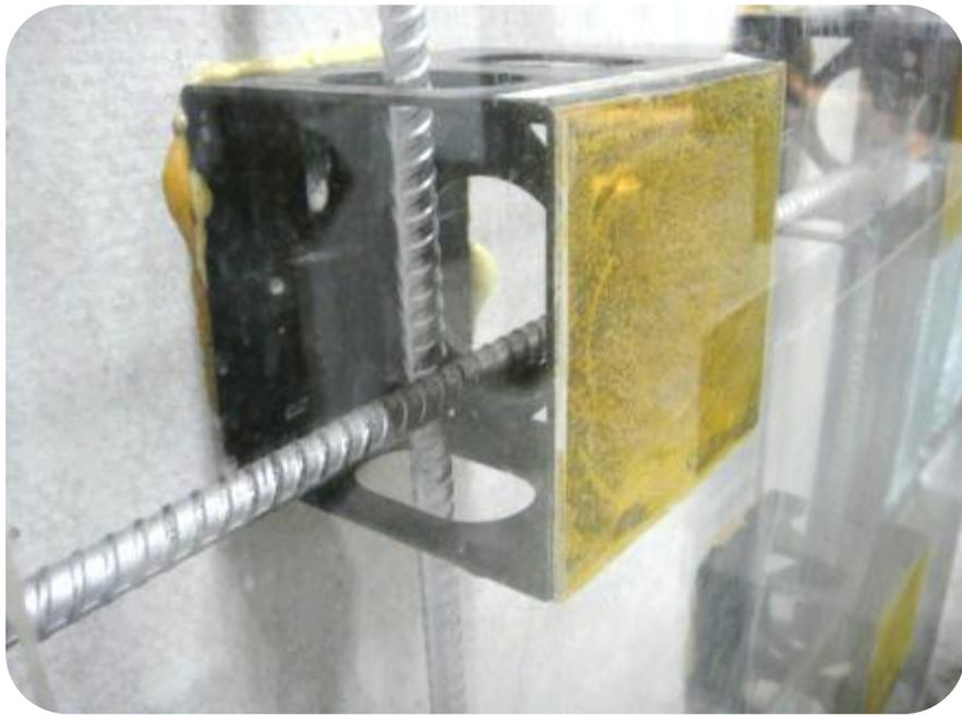
**Una vez que la pared se conecta a las otras paredes y se inserta la varilla y los ductos de electricidad o de plomería y después se llena con concreto asegurando que no existan espacios huecos dentro de los paneles creando una estructura monolítica.**
